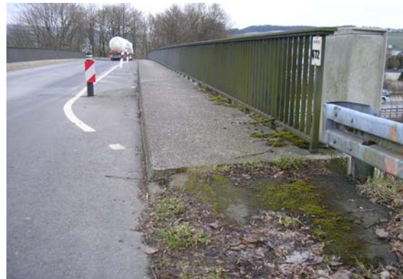
Bild 3 Einstreifige Verkehrsführung auf einer Brücke über die Autobahn zur Verhinderung von Begegnungsverkehr
