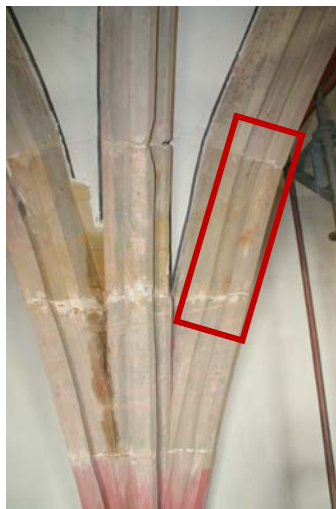
Abbildung 8. Lage der Impact-Echo- und Ultraschallechomessungen in einer gotischen Kirche in Bayreuth
