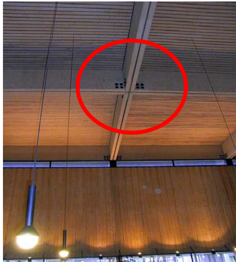
Abbildung 4. Pfarrkirche in Oberbayern mit Brettschichtholz-Trägerrost
